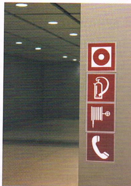
Rys. 27.6. Oznakowanie i rozmieszczenie sprzętu gaśniczego w miejscu pracy
